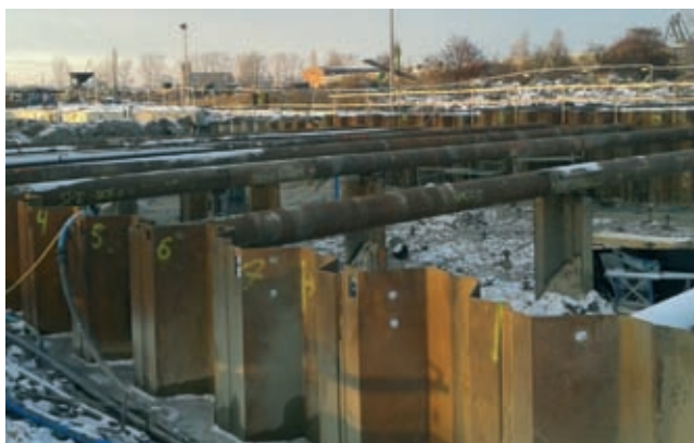
Fot. 6. Segmenty 1–8 rozparte stalowymi rurami
