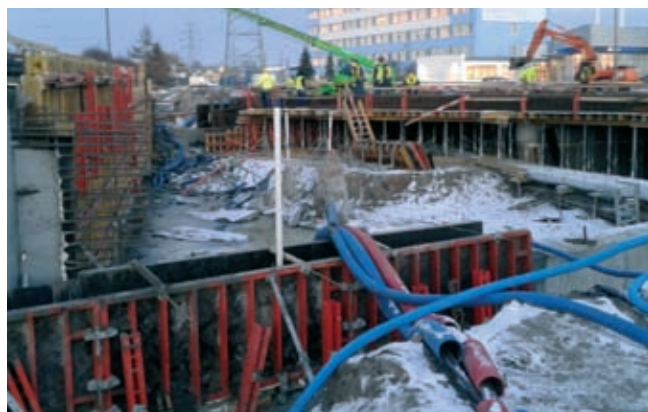
Fot. 5. Wykonywany strop segmentu 56
